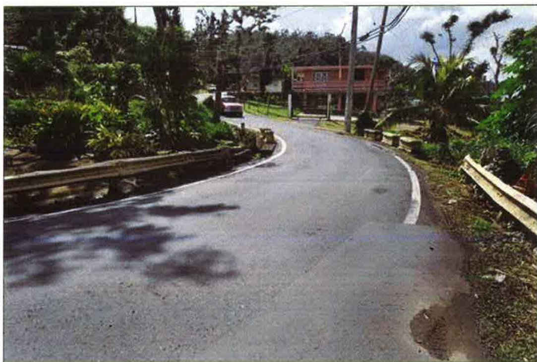
Figura 2. Fotos del Puente No 1 desde ambos extremos. Barrio Nuevo, Bayamón.
